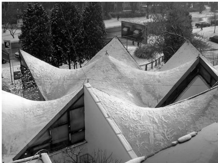
PARABOIDALNE PRZEKRYCIA PROJEKTU O. HANSENA
