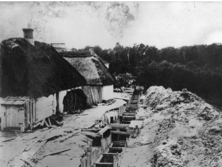
ZABUDOWA RUR W OKRESIE MIĘDZYWOJENNYM, FOTOGRAFIA ZE ZBIORÓW MPWIK, 1927, PRZEDSTAWIAJĄCA BUDOWĘ WODOCIĄGU ZE STUDNI NA WROTKOWIE DO LUBLINA.
