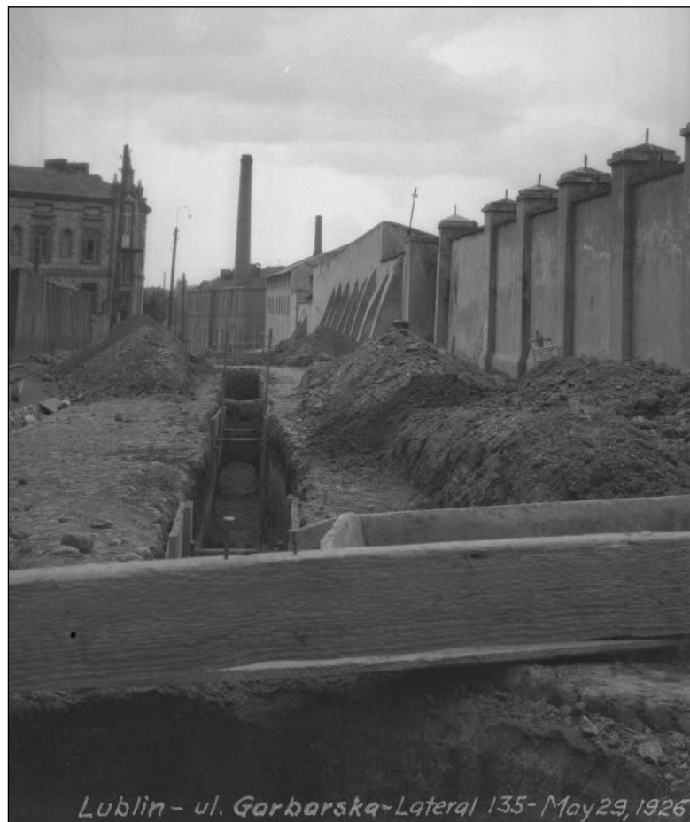
BUDOWA WODOCIĄGU NA UL. GARBARSKIEJ, 1926, W GŁĘBI WIDOCZNY BUDYNEK REKTYFIKACJI, FOT. ZE ZBIORÓW MPWIK
